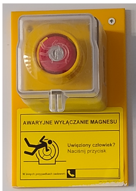
Ryc. 5 Przykładowy wyłącznik awaryjny magnesu nadprzewodzącego S-RM Źródło: Archiwum własne.
